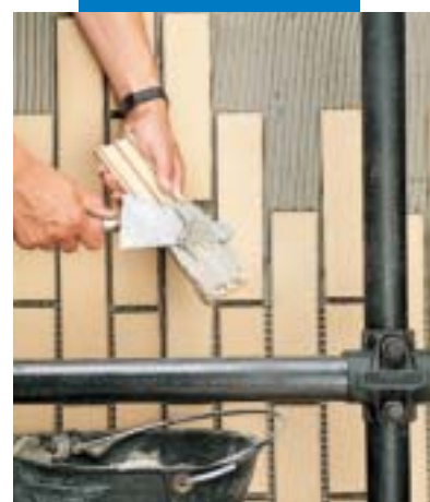
Colocación de listelos en exteriores. Nota: rellenar bien el reverso de los listelos
