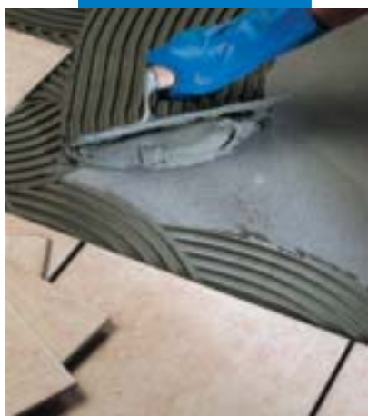
Colocación de monococción en pavimento
