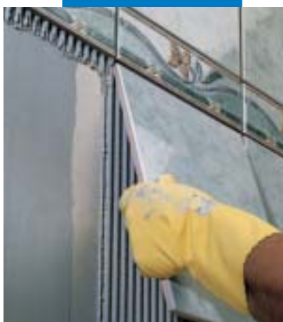
Colocación de monococción en pared sobre yeso laminado (cartón-yeso)
