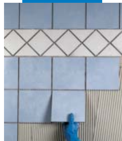
Colocación de monococción en pared de baño sobre revoco
