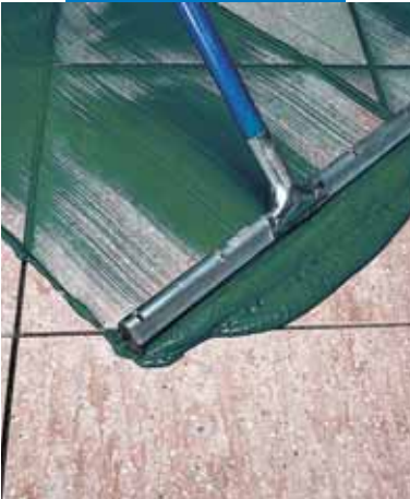
Aplicación de Ultracolor Plus en pavimento con rasqueta
