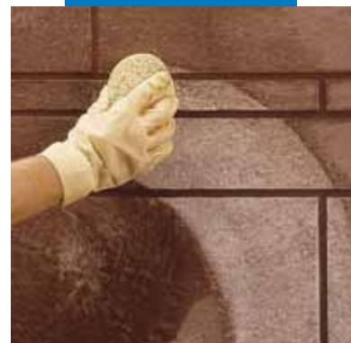
Limpieza y acabado de las juntas con esponja
