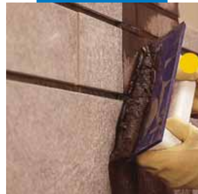
Aplicación de Ultracolor Plus en pared con llana de goma
